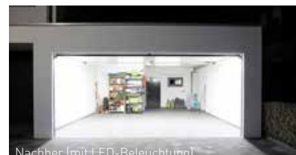
Nachher (mit LED-Beleuchtung)
